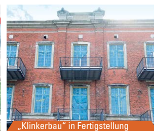
„Klinkerbau“ in Fertigstellung
