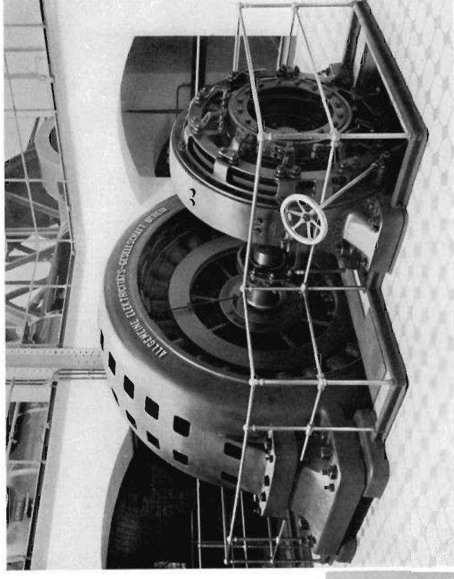
1500 PS. Generator mit Erregermaschine von der A. E. G. im neuen Betriebe
